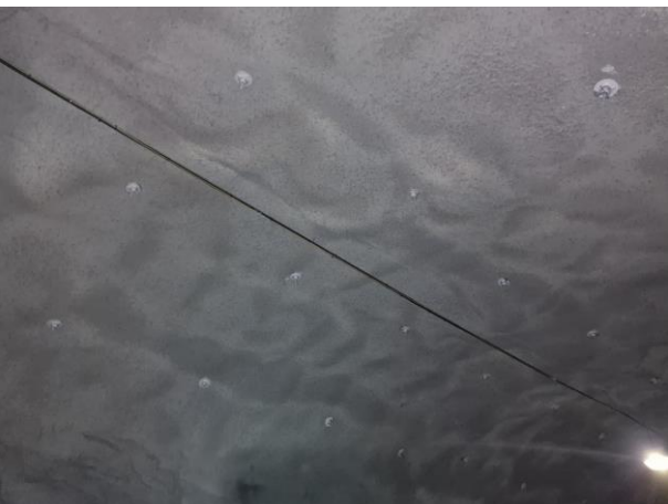
Bilde 4: Deler av tunnelen med sprøytebetong.
