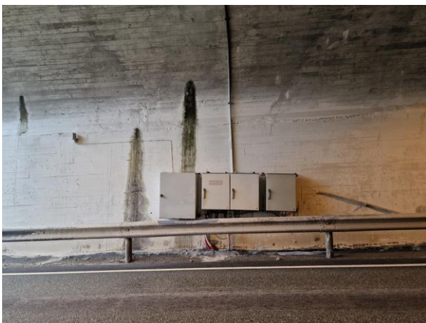
Bilde 14: EE-skap ved inngang til tunnelen
