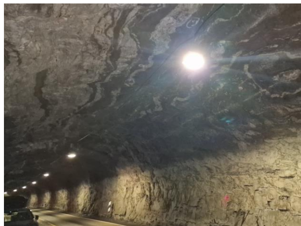
Bilde 15: kabel med lysarmaturer i taket av tunnelen
